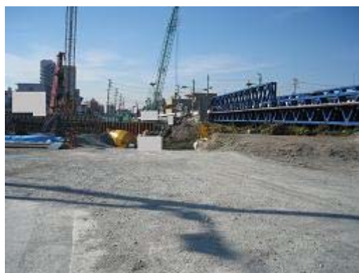
5.街路事業 植松和地線(馬込町) 鉄橋工事中
