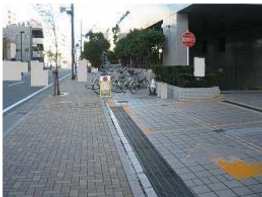
9.浜松駅前12街区 建物セットバック部分が駐輪場に
