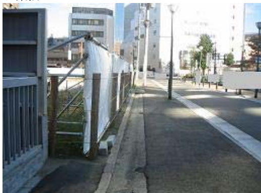
7.旭・板屋地区 A-2棟 開発予定地 歩道が広がる
