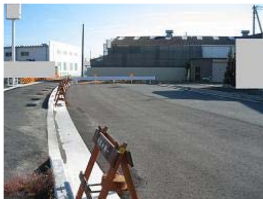
6.街路事業 高林芳川線(和田町) 水道・ガス管などの埋設はない
