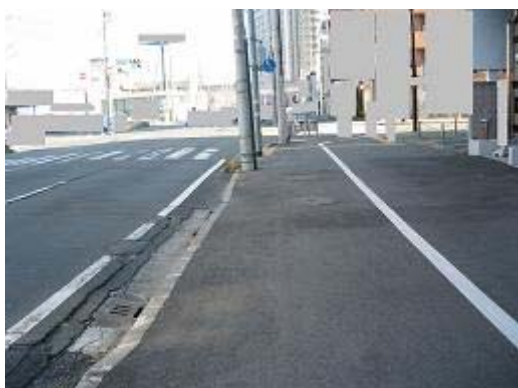
3.街路事業 植松和地線(元浜町) 工事中
