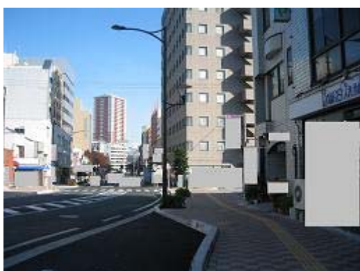
2.街路事業 旭町鴨江線(栄町) 街路樹が少ない
