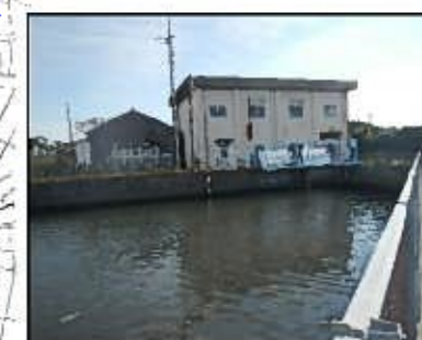
田尻排水機場
