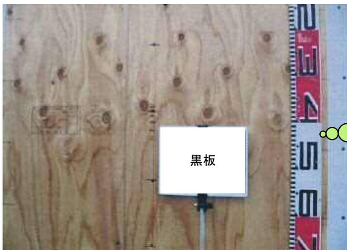
壁補強工事(構造用合板+筋かい)
