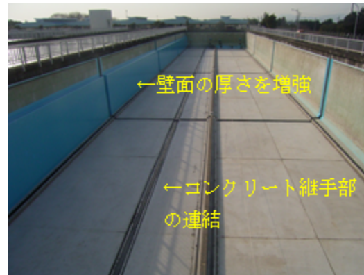
[参考] 沈澱池の耐震化
