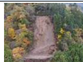
山間部における土砂崩れ
