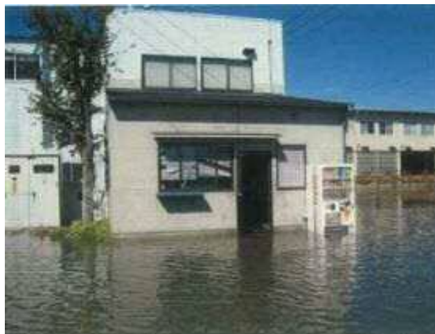
平成 26 年 10 月降雨での浸水状況 (新橋町内)
