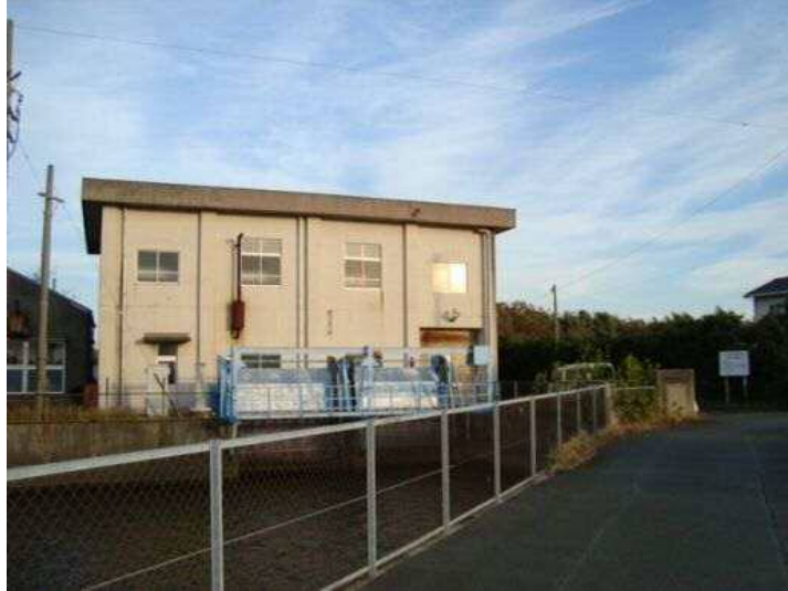
田尻排水機場
