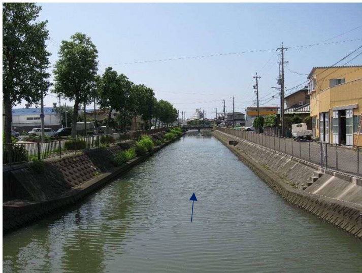
高塚川の整備（湛水防除事業での護岸等整備）
