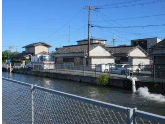
緊急時のポンプによる排水
