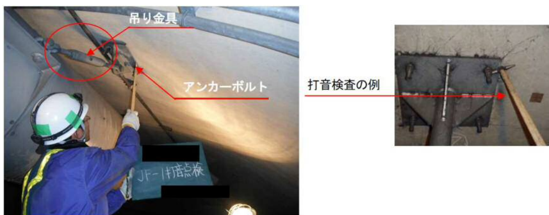
写真-解 6.3 打音検査作業状況（附属物）
