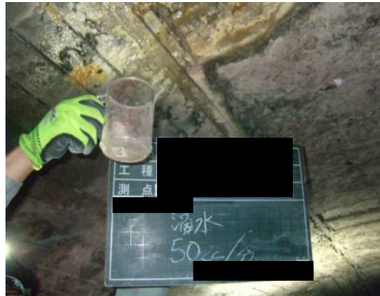
写真-解 6.5 漏水量測定作業状況
