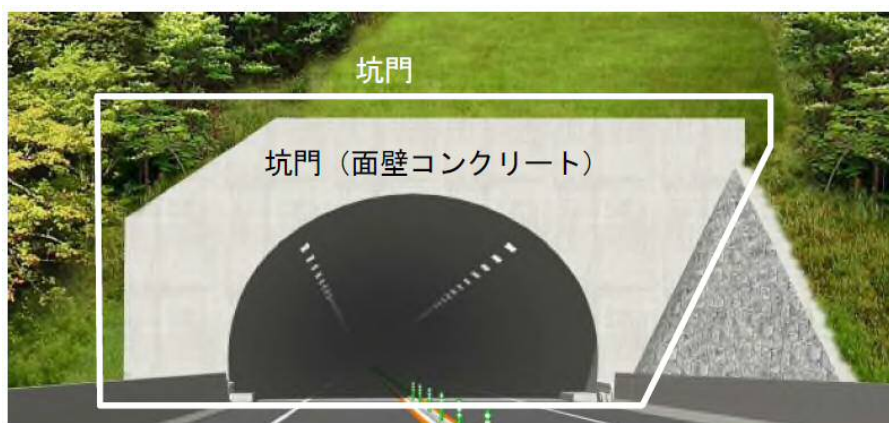
図 5.2 点検対象箇所（トンネル坑口部）
