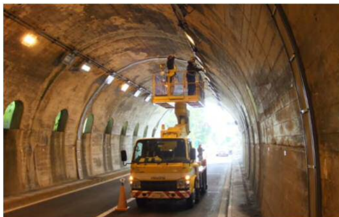
写真-解 6.1 近接目視作業状況
