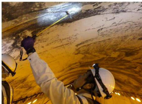
写真-解 6.2 打音検査作業状況（トンネル本体工）
