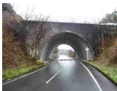
写真 2-5 アーチカルバート (市道三ヶ日摩訶耶宇志線カルバート)
