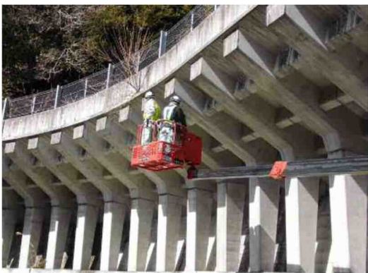
写真 4-1 高所作業車による近接目視点検
