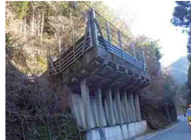
写真 2-3 落石防護棚 (国道 152 号シェッド 1)
