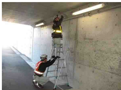
写真 4-2 梯子による近接目視点検
