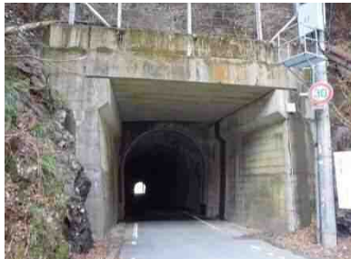
写真 2-2 門形式シェッド (県道水窪森線シェッド 4)
