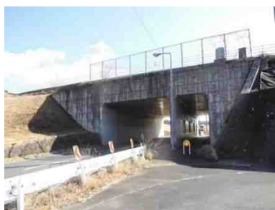
写真 2-4 ボックスカルバート (県道二俣浜松線カルバート 1)
