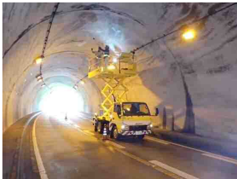
写真 4-1 トンネル点検車による近接目視点検
