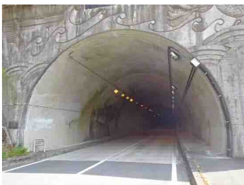
写真 2-1 NATM 工法 (豆こぼしトンネル)
