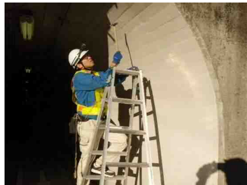
写真 4-2 梯子による近接目視点検
