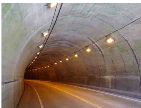
写真 2-2 矢板工法 (大川トンネル)
