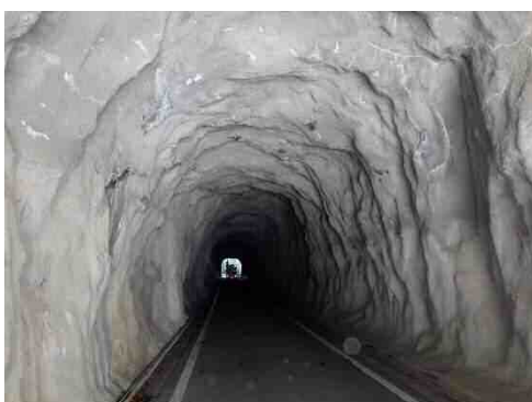
写真 2-3 その他（吹付工法） (大島第1隧道)
