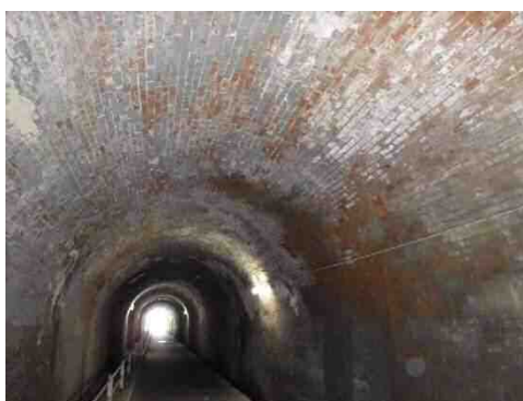
写真 2-4 その他（レンガ工法） (鳥羽山洞門)
