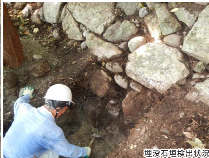
石垣の裏込め検出状況
