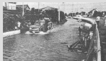
旧雄踏町の道路冠水の様子(1979年)
