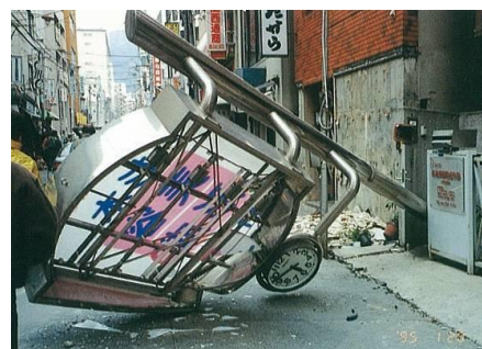
屋外物の落下による被害例
