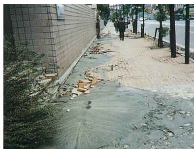
液状化による被害例
