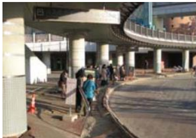
浦安市における地盤沈下の被害例
