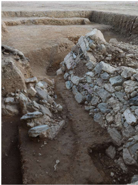
崩落した石垣と本丸北東隅石垣
