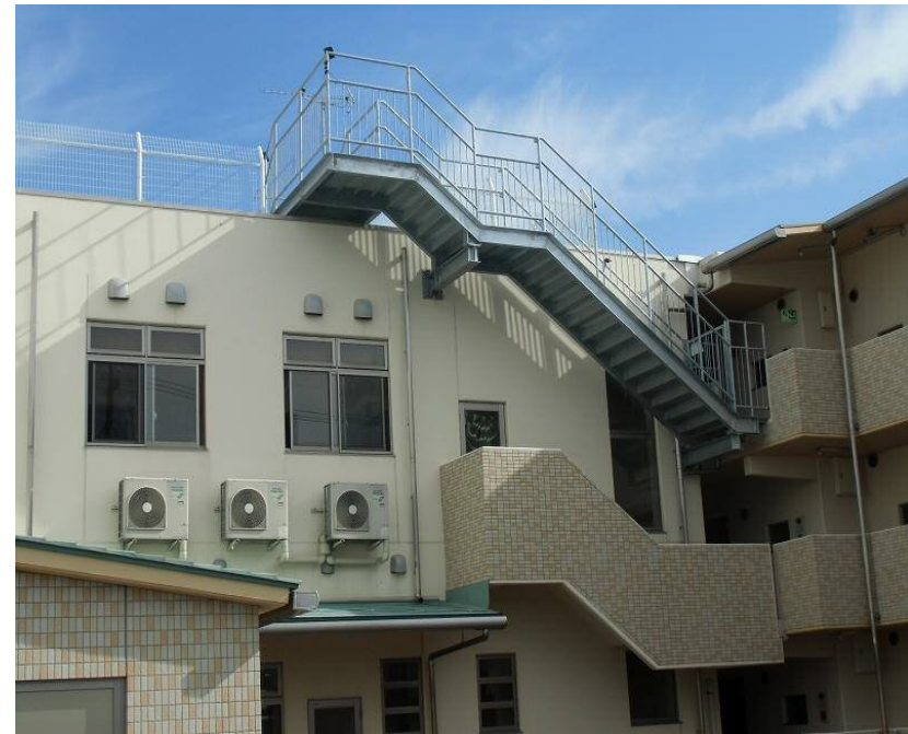
津波避難施設整備事業費補助金を活用した 津波避難ビル(浜松市南区新橋町)
