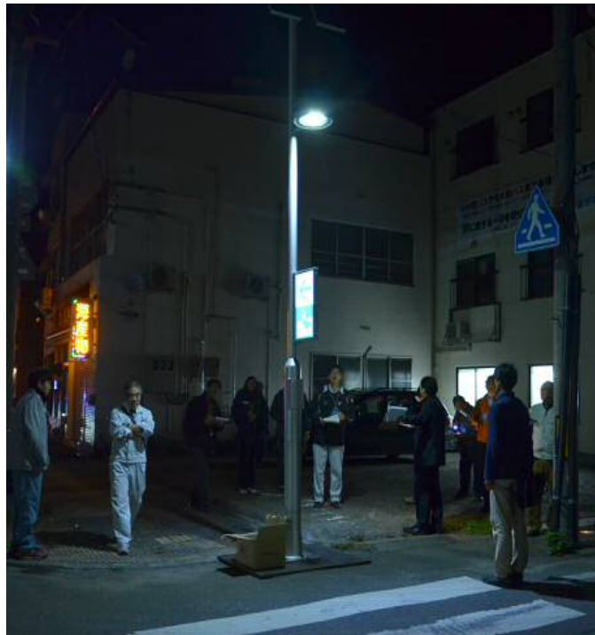
夜間照明(岩手県釜石市)
