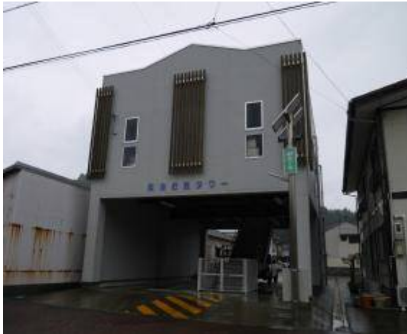
津波避難ビルを兼ねた集会所 (和歌山県太地町)
