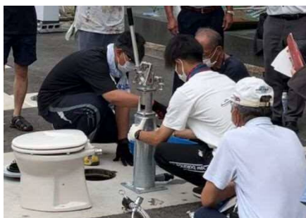
＜マンホールトイレ設置訓練＞
