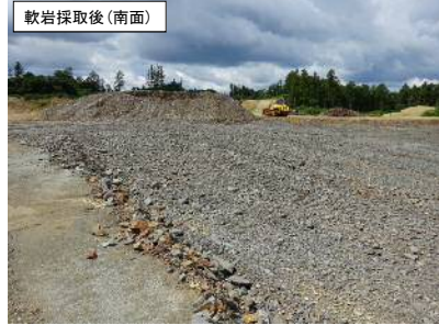
CSG材(破碎後)
