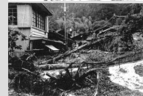
土石流による被害の様子(昭和44年、旧春野町若身)
