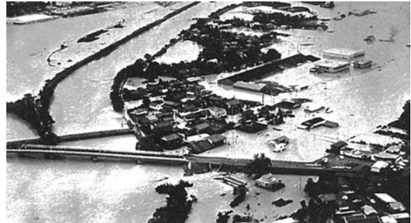
都田川と井伊谷川の合流部周辺における浸水被害の状況(1974年)
