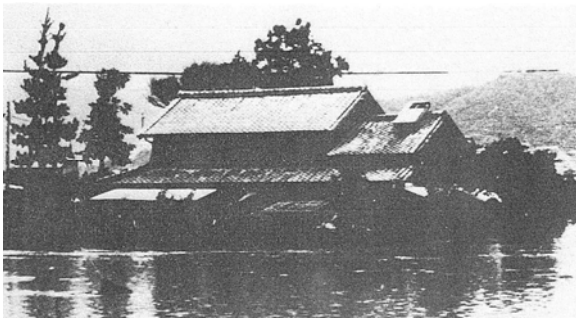
浸水の様子 (旧引佐町谷津橋付近,1974年)
