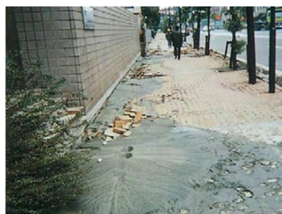
液状化による被害例
