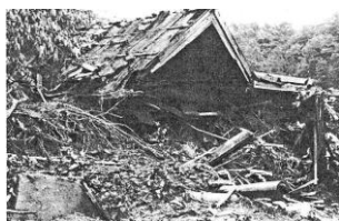
堀谷地内のがけ崩れによる被害の様子 (1974 年)
