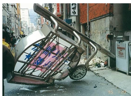
屋外物の落下による被害例
