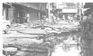
宮口地内の洪水被害の様子 (1974 年)
