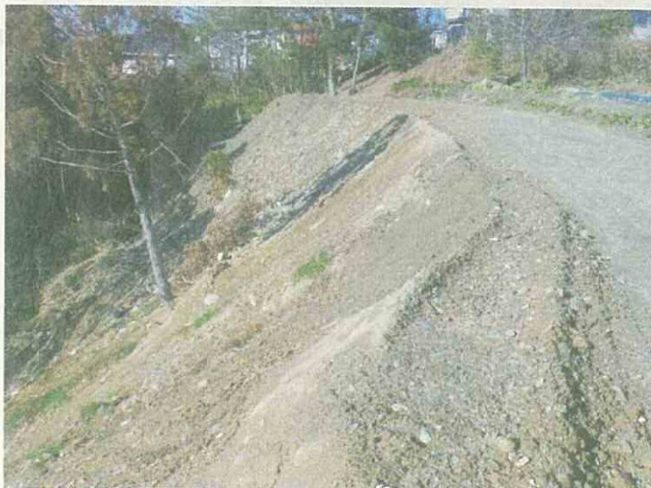
南側斜面の状況
