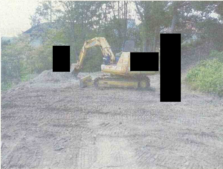
埋立地奥（西側）バックホーの状況
