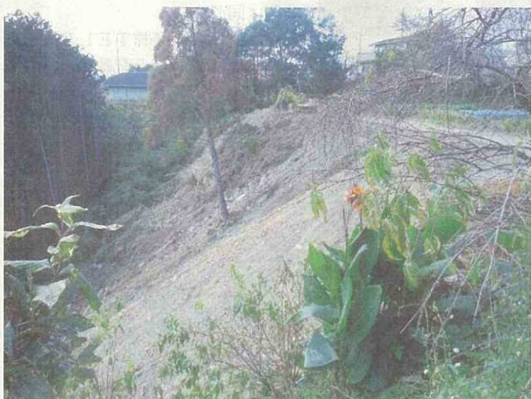
南側の法面の状況
