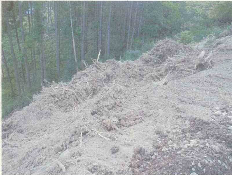
南側法面木の根投棄状況
