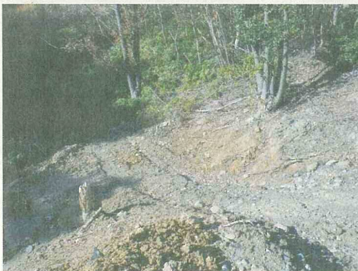
西側の状況 (以前、投棄されていた瓦は撤去されていた)
