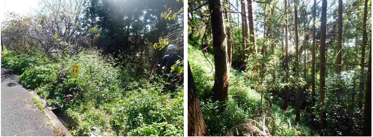
写真-7.1.3 区間④ 斜面内の状況（2022年10月26日撮影）
