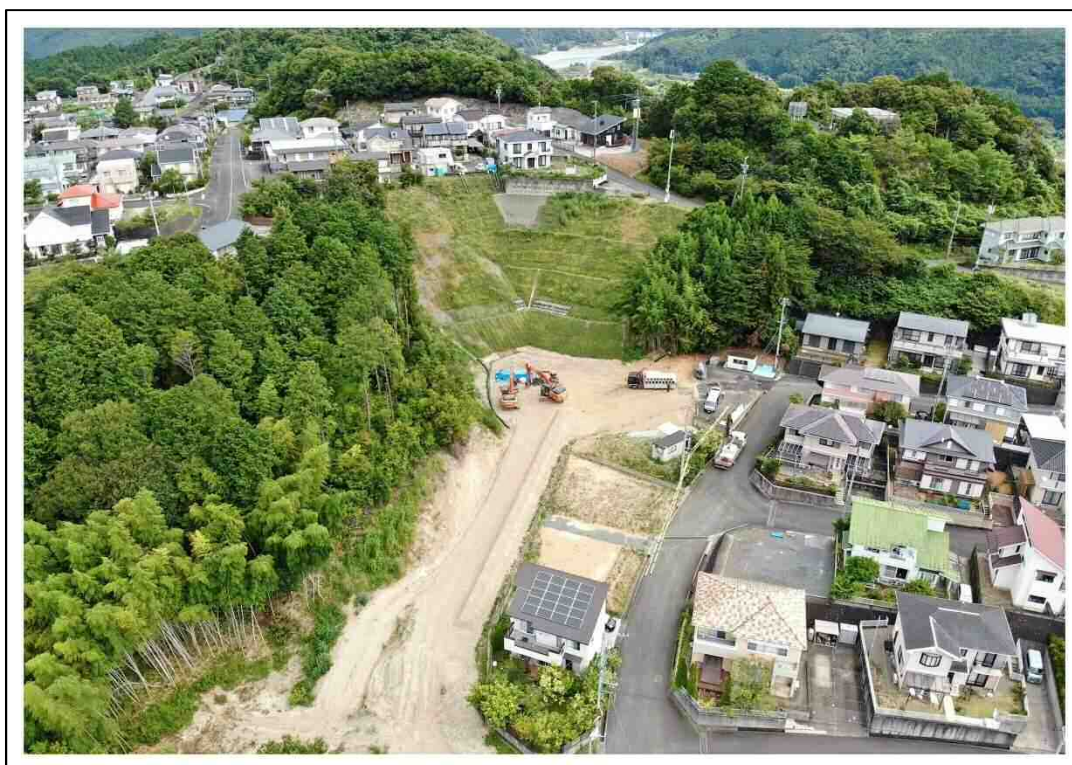
写真-1 現在の緑恵台土砂崩落現場の状況（2023年8月3日撮影）
