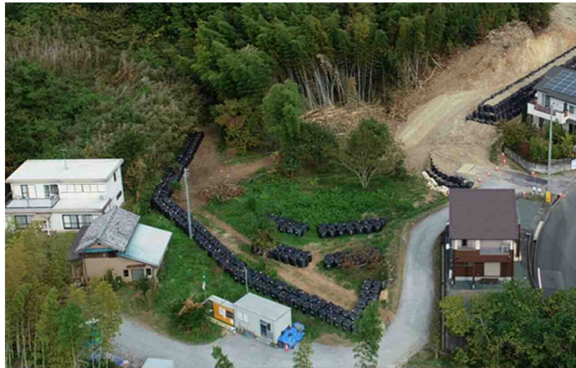
写真-6.2.1 沈砂池（2022年11月7日撮影）
