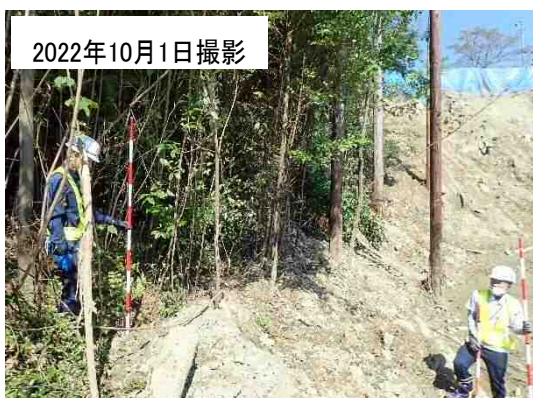
写真-7.1.5 盛り土部周縁斜面の状況
