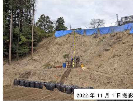
写真-4.1.5 副測線 B-M 付近の斜面状況
