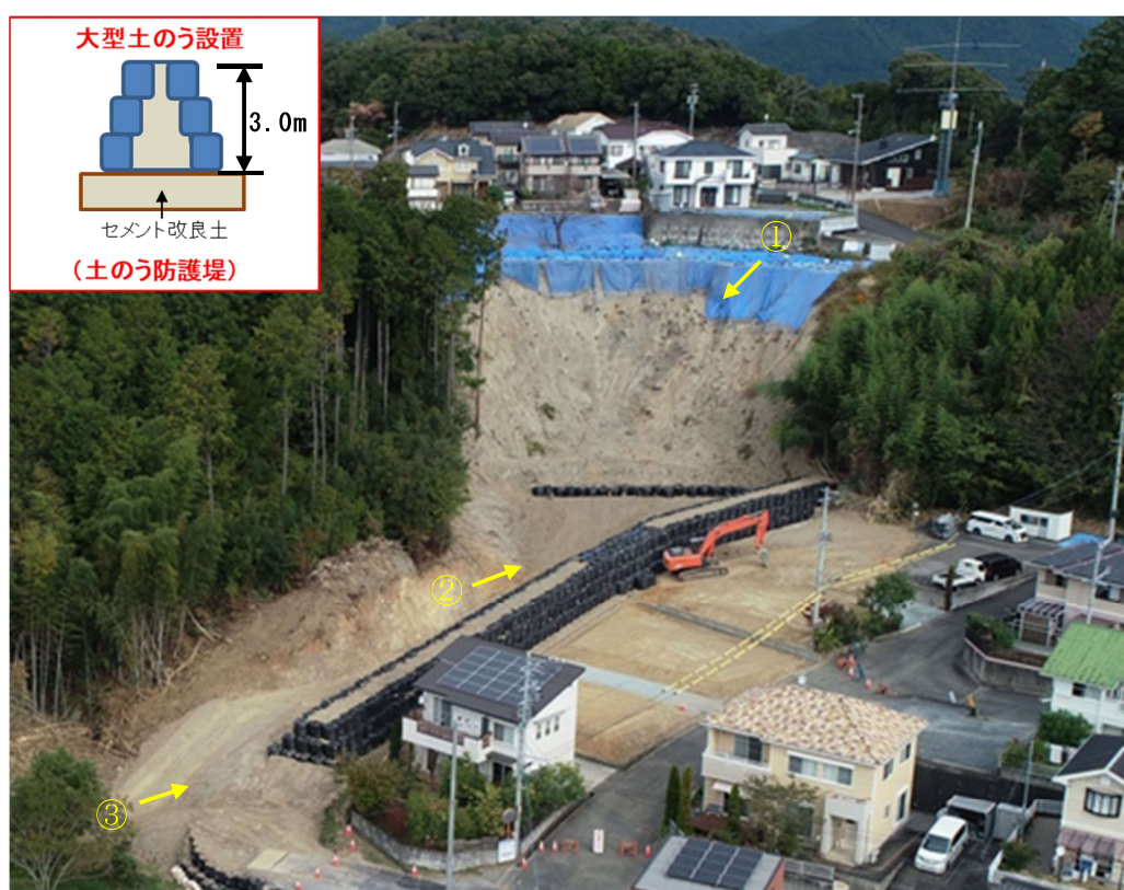
写真-6.1.1 大型土のう築堤工完成状況（全景）
