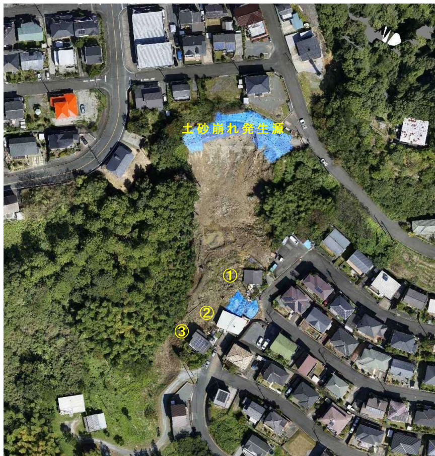
写真-5.1.2 崩落後の被害状況
