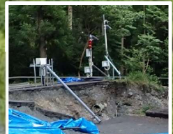
観測計器設置
