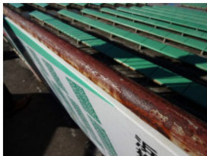
【浜松球場外周】 鉄柵等の錆・腐食
