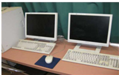
【電光掲示板システム】 コンピューター動作不良
