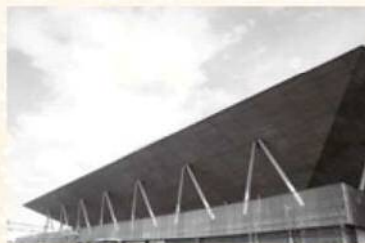
天竜材 (FSC認証材)が 納材された 有明体操競技場
