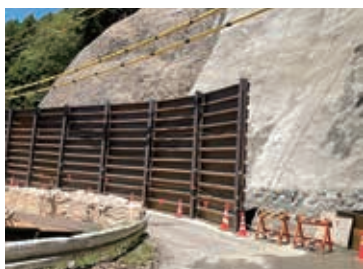
災害復旧事業債を活用した農道敷原五和線の工事
