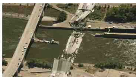
写真1 橋梁崩落事故の状況
