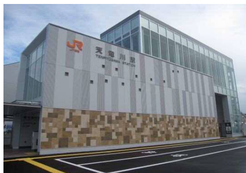
橋上駅舎、自由通路の整備 (JR天竜川駅 平成29年9月供用)
