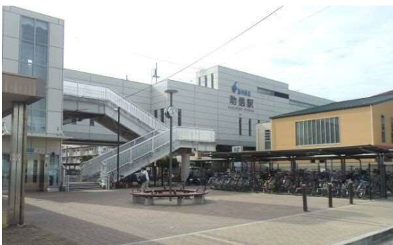
自転車駐輪場の整備 (助信駅東口 平成25年12月完成)
