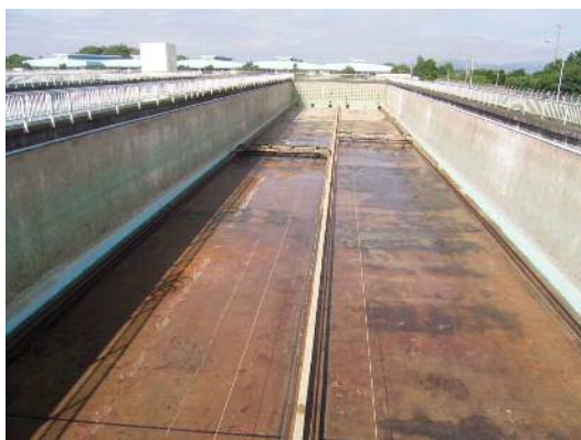
[参考] 耐震補強前の沈澱池
