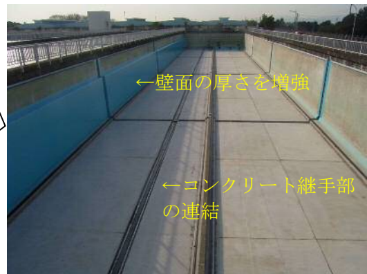
[参考] 耐震補強後の沈澱池
