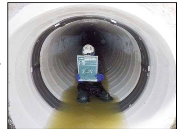
<改築後>管更生を実施した管路
