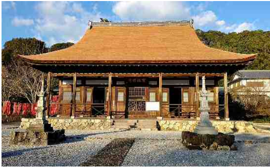
ほうりんじ ぶつでん ほうじょう 宝林寺 仏殿・方丈（北区細江町中川：国指定重要文化財建造物）
