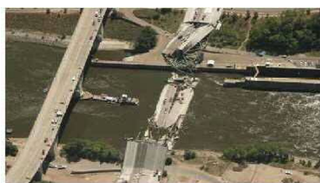
写真1 橋梁崩落事故の状況
