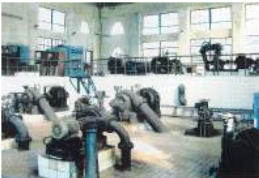
きゅうすみよしじょうすいじょう 旧住吉浄水場ポンプ室ほか（中区住吉五丁目、東区常光町：国登録有形文化財 建造物）
